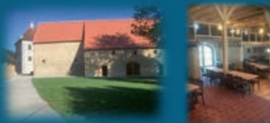
Sanierung Hammerschloss-Areal Schloss-Stadl
