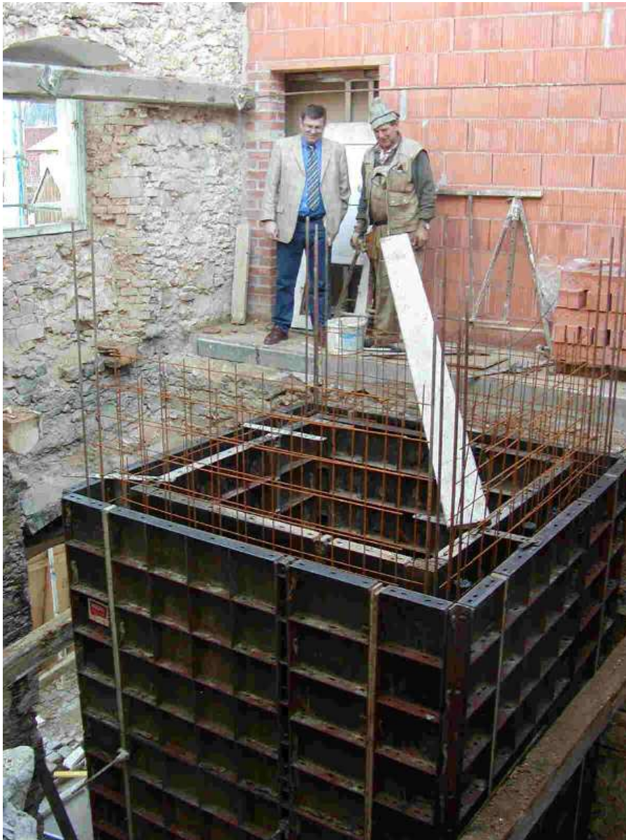
Bild zeigt die Einschalung für den neuen Aufzug
