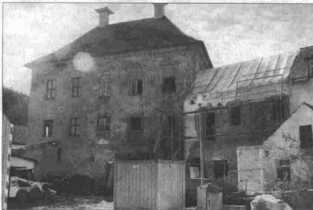
Noch heuer stehen Arbeiten an der Außenfassade an; die Fenster werden in die ursprüngliche Größe zurückversetzt, wie links oben schon zu sehen.
