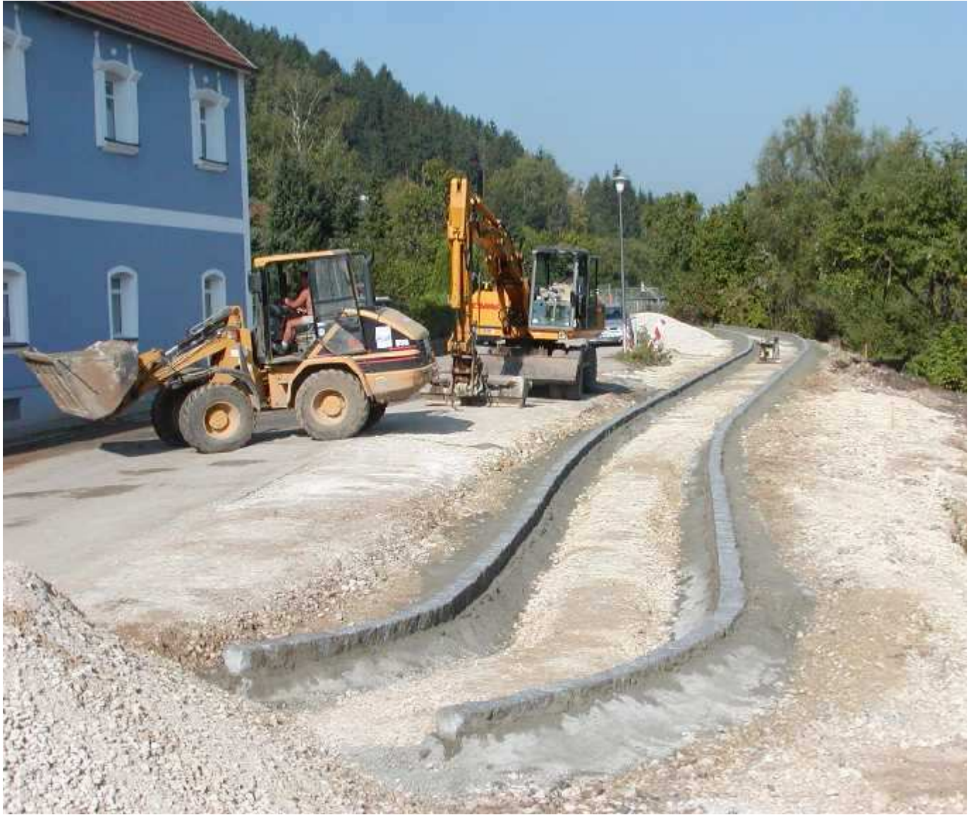
Bild zeigt die Bauarbeiten in der Dr. Pfab – Straße / Schulweg für alle Kinder
