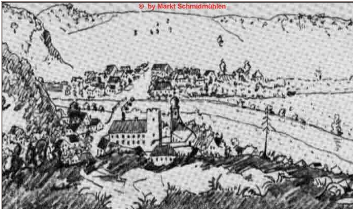
Emhof zum Ende des 18. Jahrhunderts. Der neben der Kirche sichtbare hohe Turm wurde 1816 abgebroche
