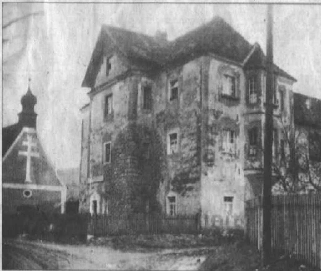
Ein Großbrand vernichtete das Ziegler Schloss am 26. November 1896. Die Ursache wurde nie geklärt, Brandstiftung wurde aber nicht ausgeschlossen.
