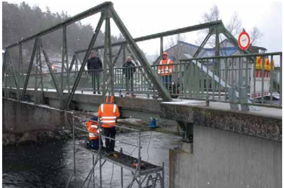
Die stellvertretenden Bürgermeister Martin Bauer und Mathias Huger überzeugten sich vor Ort vom Fortschritt der Sanierungsarbeiten.
