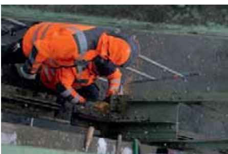
Der Blick von oben auf die Sanierungsarbeiten.
